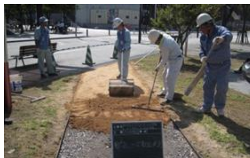
施行中：自然素材だけの舗装材
